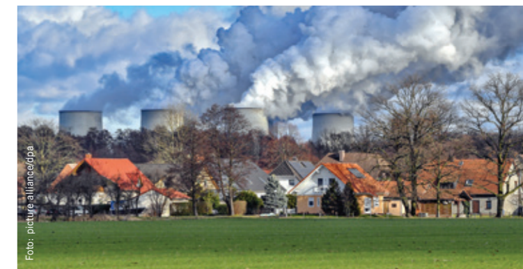
Raus aus der Kohle – Noch steigt Wasserdampf aus den Kühltürmen eines Braunkohlekraftwerkes in der Lausitz.
